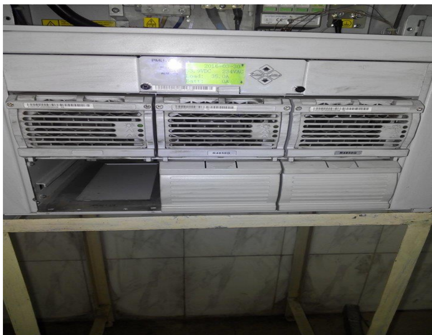
Fig19: Rectifier Module.
